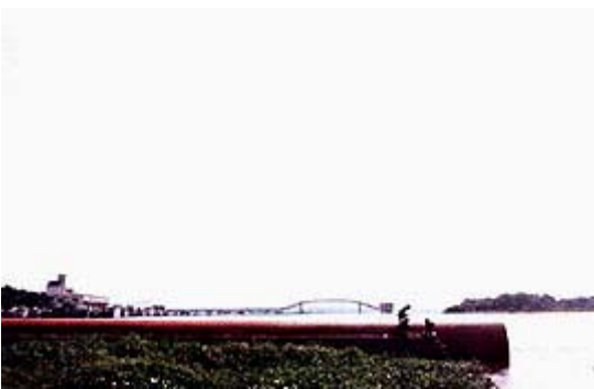
Jovens pescam na saída da tubulação de esgoto. Corumbá (MS).
